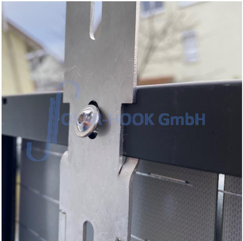
Abb. 5/locker angesetzte Schraube M6 kurz
