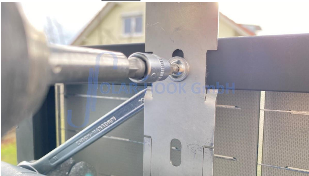
Abb. 16/Anziehen der kurzen Schrauben
