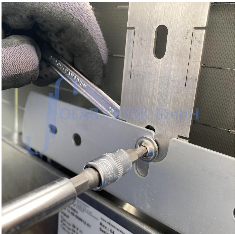
Abb. 6/Wechselrichter am SOLAR-HOOK Befestigungsbügel anschrauben
